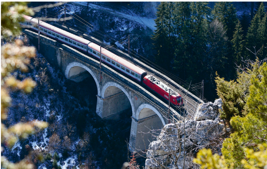
Abb. 1: Blick von der Pollereswand auf das Viadukt Kalte Rinne .
