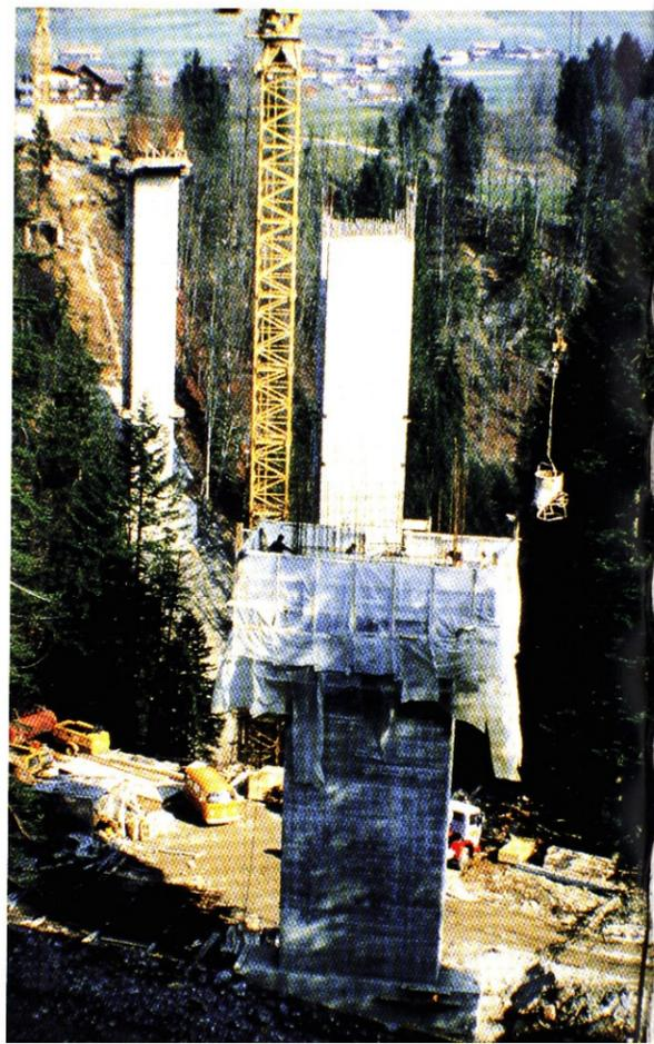
biegesteif mit dem Tragwerk verbunden sind, mußte gleichzeitig eine ausgewogene Steifigkeitsverteilung im Endzustand erzielt werden. Die großen Schlankheiten der freistehenden Pfeiler im Bauzustand erforderten temporäre Versteifungsmaßnahmen in Form von stählernen Doppelkreuzen.
