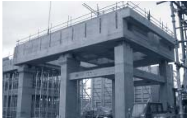
Abbildung 10: Dampfturbinentisch im Bauzustand (KW Coolkeeragh)
