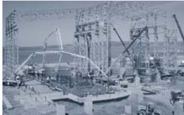
Abbildung 4: Drei Betonpumpen betонieren das Gasturbinenfundament (KW Ankara)
