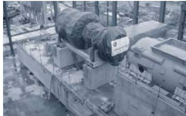
Abbildung 6: Die Gasturbine auf dem Blockfundament (KW Coolkeeragh)
