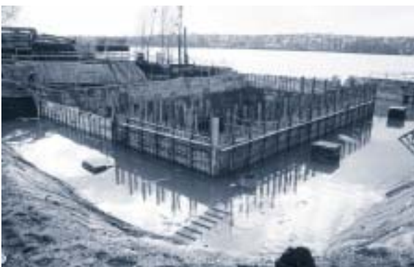
Abbildung 15: Fast geflutete Baugrube des Kühlwassereinführungsbauwerks (KW Csepel II in Budapest)
