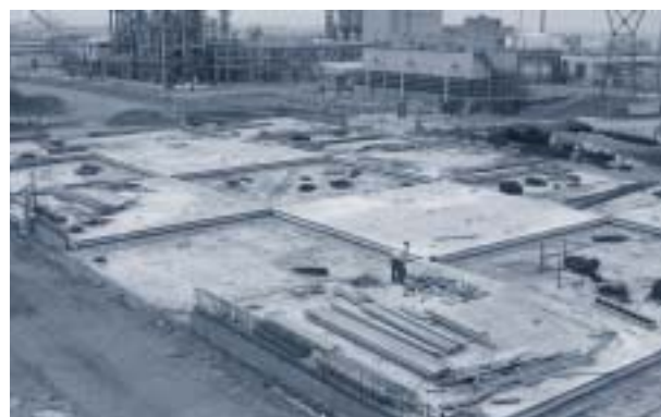
Abbildung 17: Bodenplatte des Kühlturmbeckens (KW Thessaloniki)
