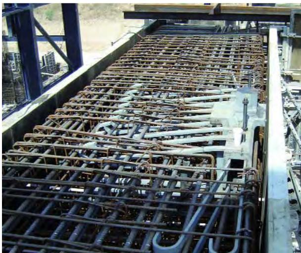
Abb. 5.40 Maßgeschneiderter Stahleinbauteil in einem Dampfturbinenfundament. Foto Uzunoglu
