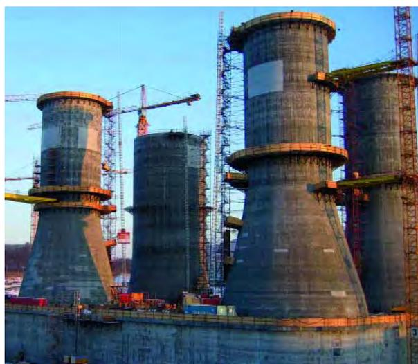
**Abb. 5.5** Off-Shore-Plattform Sakhalin, 2005, Herstellung im Trockendock in Gleitbauweise mit österreichischer Technik. Foto Gleitbau
