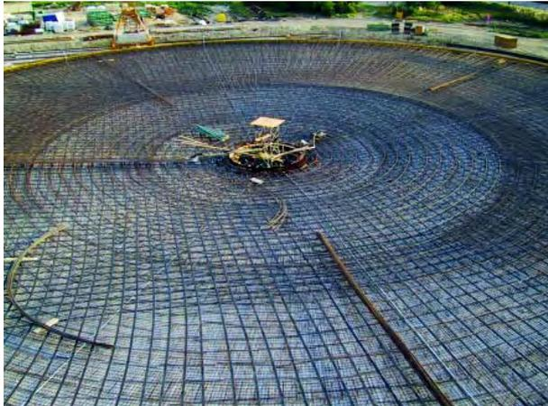
**Abb. 5.25** Zentralkläranlage Wien; Beckenboden mit verbundloser Vorspannung 2002/05.
