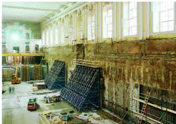
Abb. 5.57 Museumsquartier Wien; Umbau der Winterreithalle zur Veranstaltungshalle, Bau des neuen Untergeschoßes nach den Prinzipien der "Weißen Wanne"
