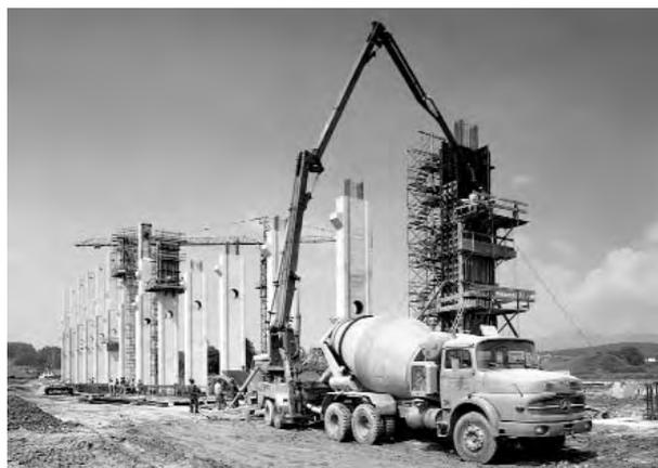
**Abb. 5.10** (a) Betoneinbringung mit Krankübel; (b) Transportbetonfahrzeug bei Betonübergabe, Betoneinbau mit mobiler Betonpumpe. Foto Gerlach
