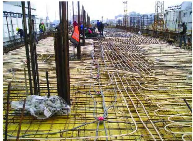
**Abb. 5.29** TownTown-Komplexe in Wien 2006; Rohrregister zur "Betonkernaktivierung" in einer Stahlbetondecke. Foto Strabag
