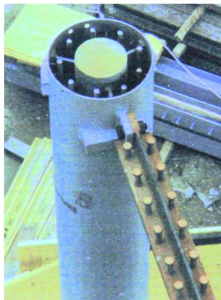
**Abb. 5.53** Millenniumstower; Anschluss Slim-Decken-Träger an Verbundstütze
