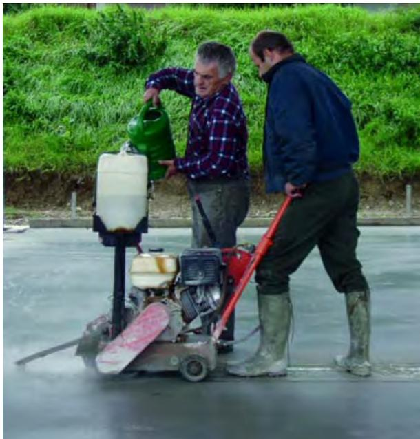
**Abb. 5.12** Schneiden von Fugen einer Industrie-Bodenplatte
