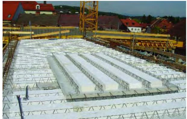
**Abb. 5.16** City-Arkaden Klagenfurt, 2004, Elementdecken mit Styroporeinlagen zur Gewichtsreduktion
