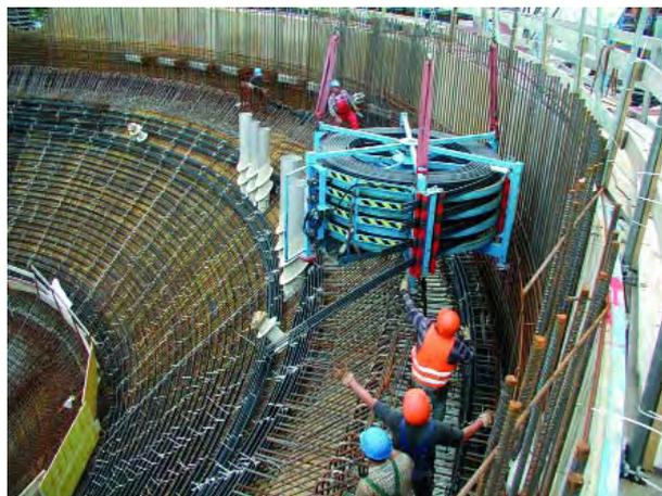
**Abb. 5.13** Verlegen von Kabeln einer verbundlosen Vorspannung mit Hilfe einer Haspel.
