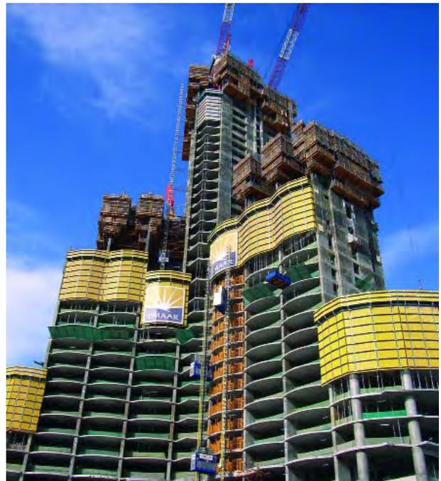
**Abb. 5.7** Burj Dubai, 600 m hoher Gebäudeteil, 2007, Herstellung im Selbstkletterverfahren mit österreichischer Technik. Foto Doka
