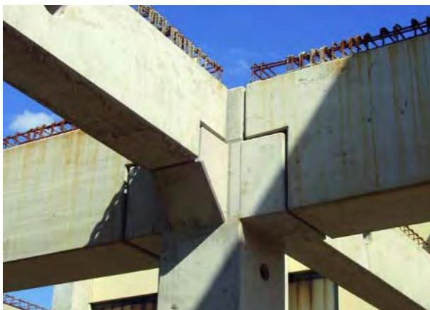
Abb. 5.41 ADEG-Markt Spittal/Drau, Kreuzung von Fertigteilträgern auf einer Fertigteilstütze 2004
