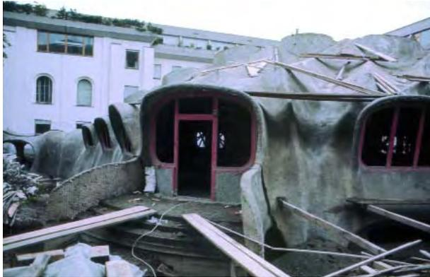
**Abb. 5.60b** Mehrzwecksaal des Internats der Grazer Schulschwestern in der Bauphase 1977; Spritzbetonschale. Foto Domenig
