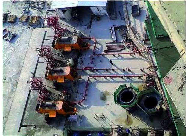
**Abb. 5.11** Stationäre Betonpumpen beim Burj Dubai mit Förderhöhen bis 600 m, 2007. Foto Gleitbau
