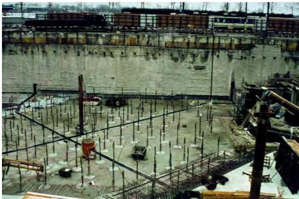
**Abb. 5.51** Millenniumstower Wien 1999; Hochhausfundierung. Foto Kollitsch & Stanek
