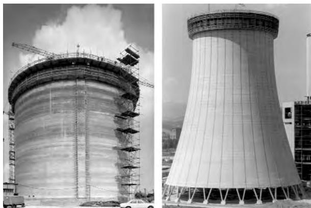
**Abb. 5.3** (a) Zuckersilo Tulln, Herstellung in Gleitbauweise 1978, (b) Kühlturm Voitsberg, Errichtung in Kletterbauweise 1983. Fotos Jeschofnik, Gerlach
