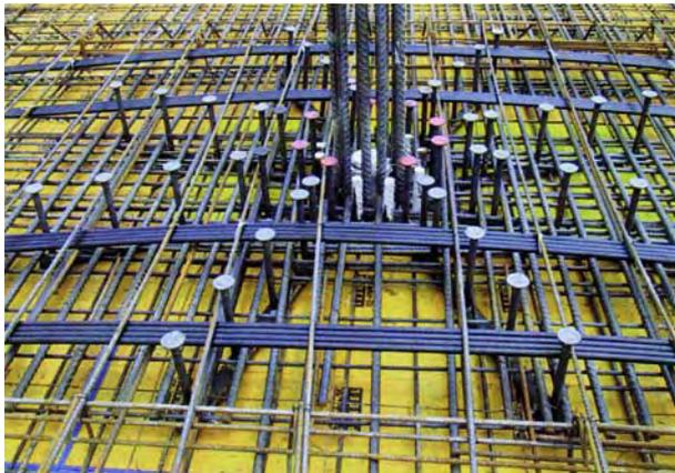
**Abb. 5.28** Durchstanzbewehrung und verbundlose Vorspannung bei einer Flachecke
