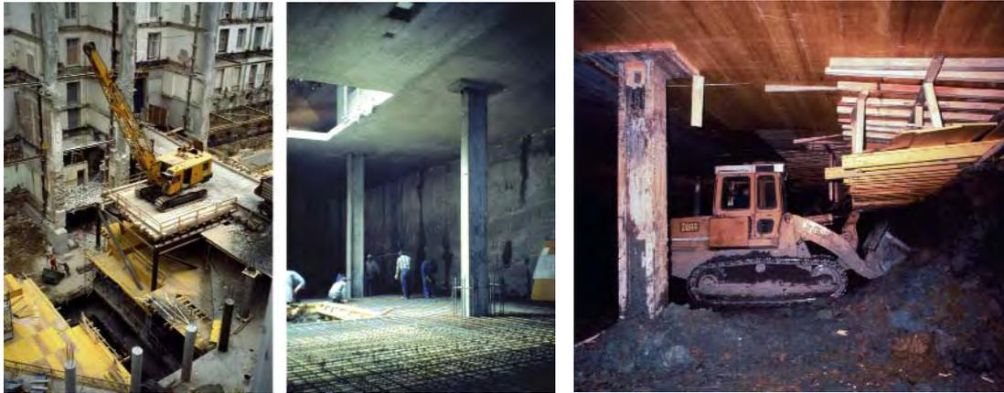
**Abb. 5.34** Grand Hotel & Palais Corso Wien, Deckelbauweise 1993; (a) Herstellung einer "Vorbau"-Decke; (b) Zu- und Abtransport durch eine Deckelöffnung; (c) Erdaushub unter einer "Vorbau"-Decke
