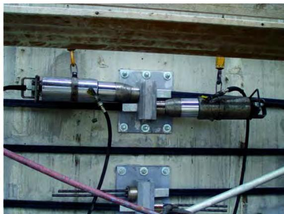
**Abb. 5.27** Kläranlage Knittelfeld; Sanierung eines Behälters mit verbundloser Vorspannung 2002, (a) Übersicht und (b) Detail Spannstelle.
