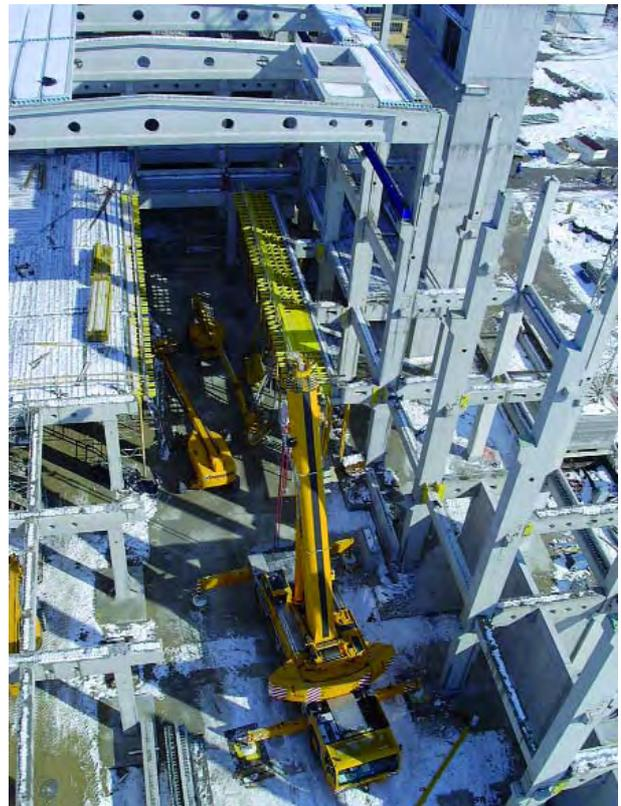
Abb. 5.21 Papierfabrik SAPPi Gratkorn; Fertigteilhalle für die größte Papiermaschine der Welt 1998. Foto Oberndorfer
