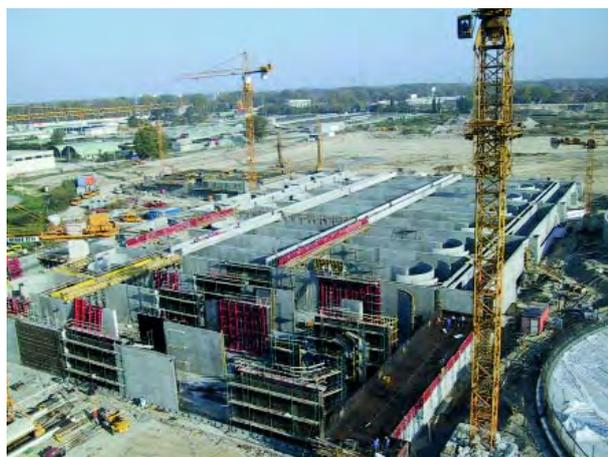
**Abb. 5.38** Hauptkläranlage Wien; Abschnittsweise Herstellung der Beckenwände nach den Prinzipien einer "Weißen Wanne" auf einer vorgespannten Bodenplatte 2002/05. Foto Vorspanntechnik
