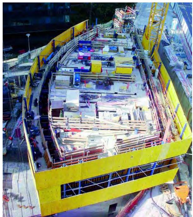
**Abb. 5.8** Hochhaus *Tour CBX* in Paris, 2004, Herstellung im Selbstkletterverfahren einschließlich Plattform mit österreichischer Technik. Foto Doka
