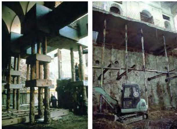
**Abb. 5.58** Museumsquartier Wien; Unterfangungen von Bestandsbauten mit Kleinbohrpfählen;
