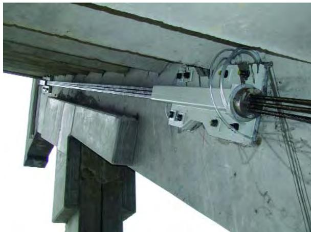
**Abb. 5.23** Hanappi-Stadion Wien; Verstärkung der Tribünenträger mit verbundloser Vorspannung, 2003. Foto Vorspanntechnik
