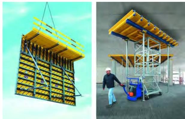
**Abb. 5.2** (a) Großflächenwandschalung beim Umsetzen, (b) Schaltisch beim Verfahren. Foto Doka
