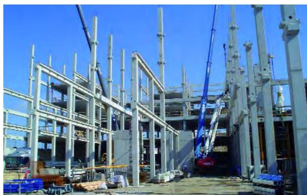
**Abb. 5.14** Hallenbauwerk – Stützen, Wände und Decken ausschließlich aus Fertigteilen. Foto Oberndorfer
