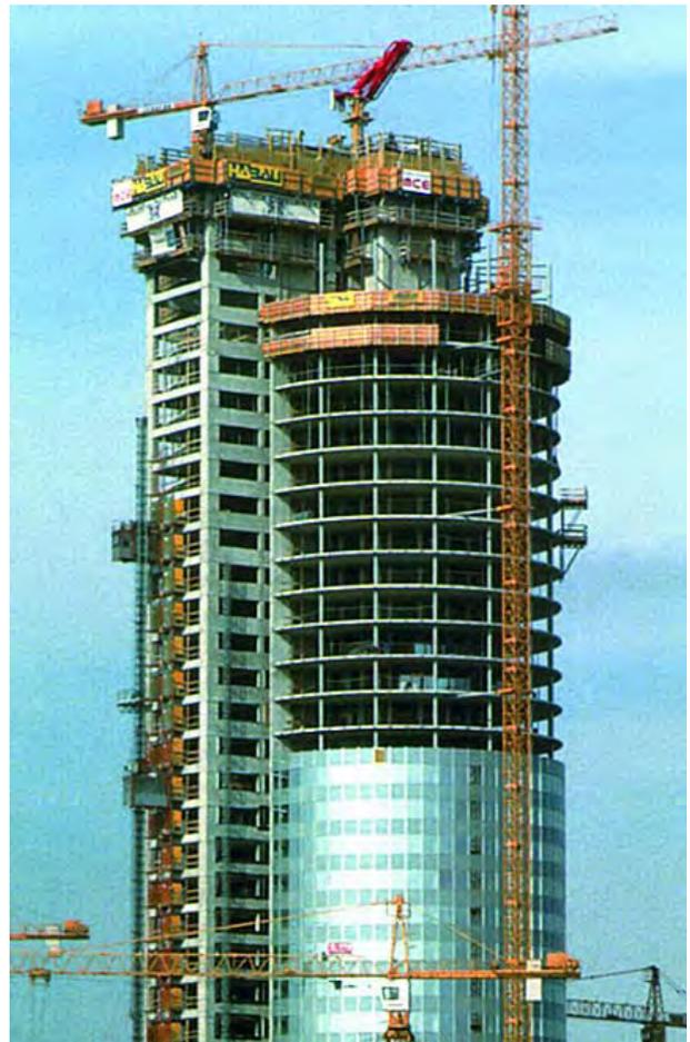
**Abb. 5.52** Millenniumstower; Herstellung Rohbau, Ausbau, Fassade
