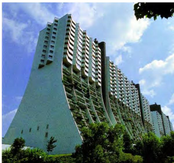
**Abb. 5.4** Wohnparkanlage Alt-Erlaa, Wien 1977, Errichtung unter Einsatz des Gleitbauverfahrens
