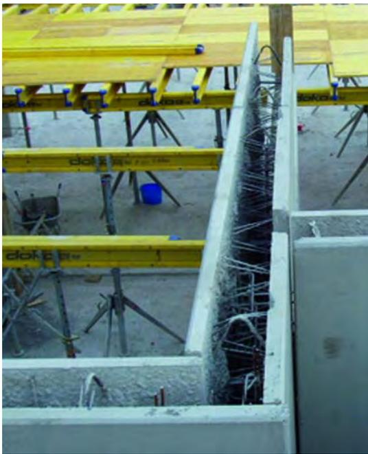
**Abb. 5.15** "Hohlwände" in Kombination mit einer Flächenschalung
