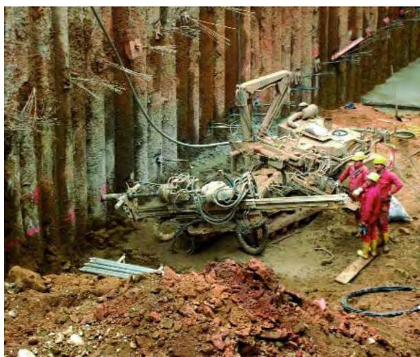
Abb. 5.33 Tiefgarage Kastner & Öhler Graz; Baugrubenverbau mit Bohrpfählen, Setzen einer Ankerlage 2003
