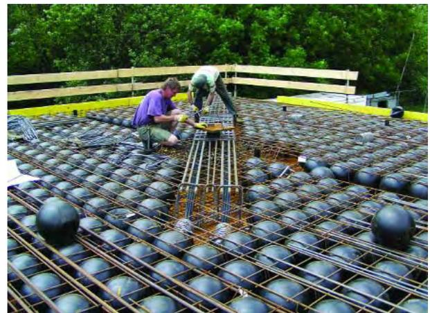
**Abb. 5.30** Travel Europe, Stans 2005, auskragende Flachdecke mit Aussparungskörpern und verbundlos vorgespanntem Plattenstreifen. Foto Cobiax
