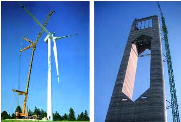
**Abb. 5.6** (a) Windkraftwerk mit Spannbetonschaft 2006; (b) Zentralturm eines Solarkraftwerks in Spanien 2005; Herstellung in Gleitbauweise mit österreichischer Technik. Fotos Gleitbau
