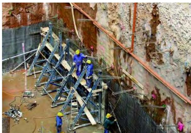
**Abb. 5.37** Tiefgarage Kastner & Öhler Graz; Aufbringen von Bentonit-Paneeelen für eine "Braune Wanne" vor dem Betonieren 2003
