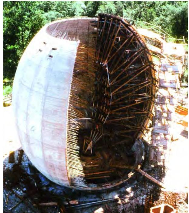
**Abb. 5.24** Kläranlage Graz, Gössendorf, Herstellung eines Faulbehälters 1971; Vorspannung mit nachträglichem Verbund. Foto Gerlach
