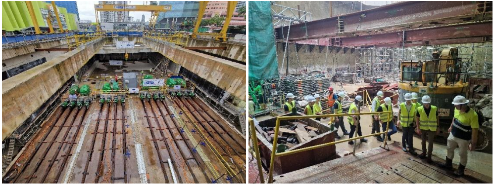
Abbildung 11.1-4: links und rechts: Baustelle North-South Corridor
