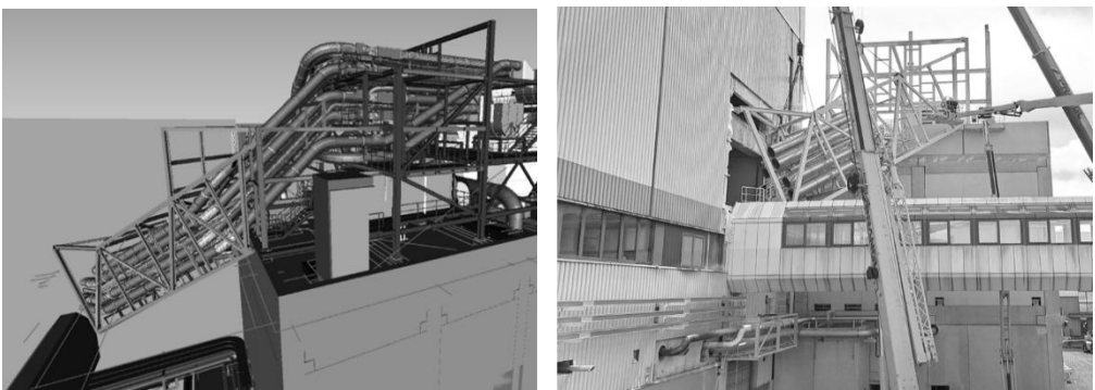
Abbildung 20.3-1: links: 3D-Planungsmodell aus Navisworks; rechts: windschiefe Rohrbrücke beim Einhub mit teilweise vorinstallierten Rohrleitungen [convex ZT GmbH]
