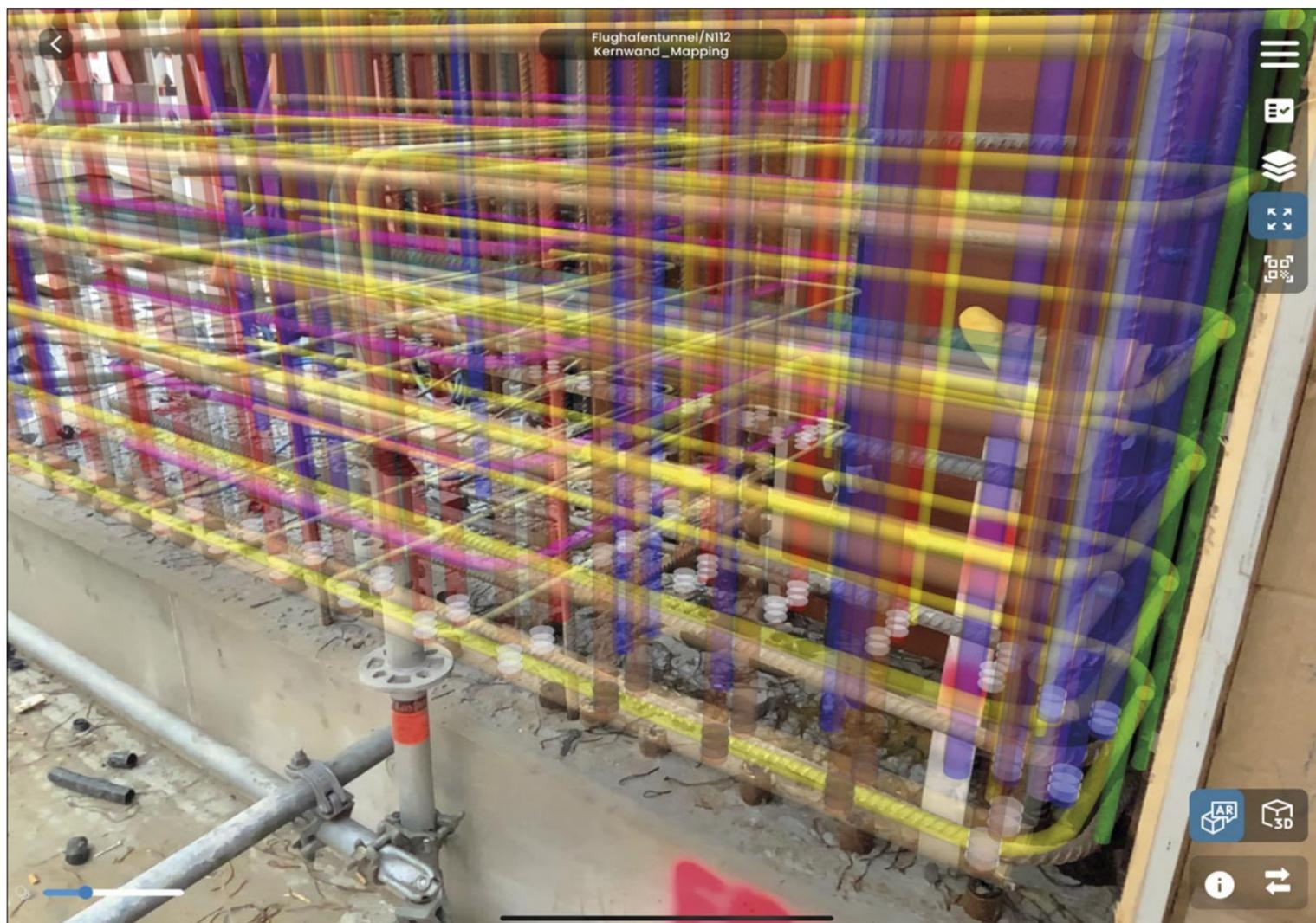
Das Modul *compare* dient vor allem der örtlichen Bauaufsicht. Mit der Augmented-Reality-App kann das 3D-Modell aus der Planung mit dem tatsächlichen Bauzustand überlagert werden. Damit wird die Kontrolle der Vollständigkeit und Richtigkeit radikal vereinfacht.
