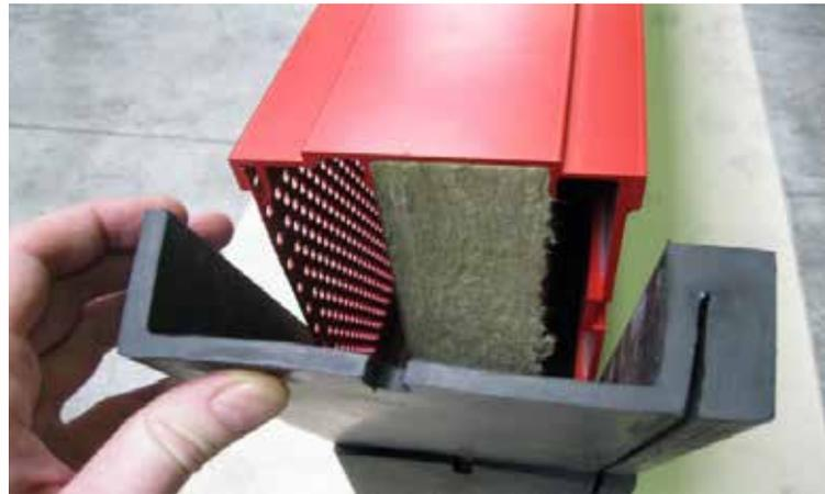
Bild 4: Stirnseitiges EPDM-Lager
