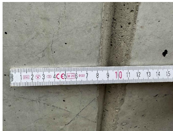
Abbildung 8 Rissbildung neben vertikalen Sollrissfuge
