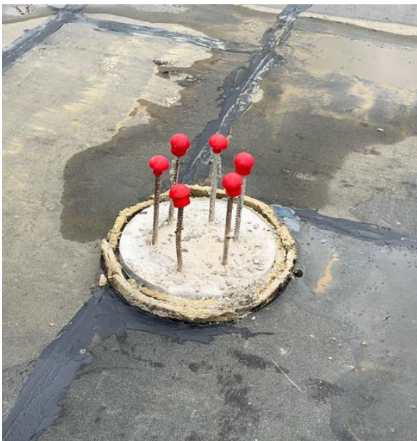
Abbildung 3 Pfahlkopf und bituminöse Gleitschicht
