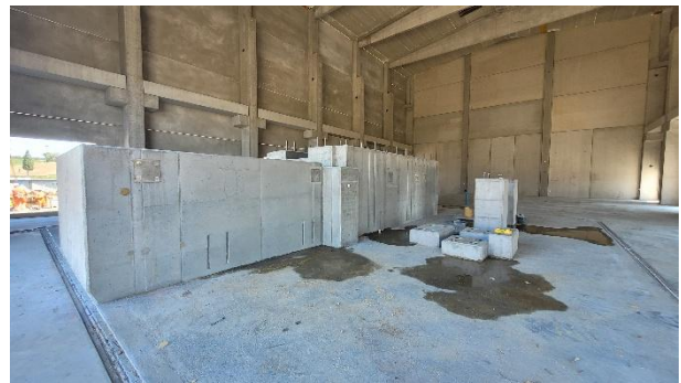
Abbildung 15 Das fertiggestellte Kompressorfundament
