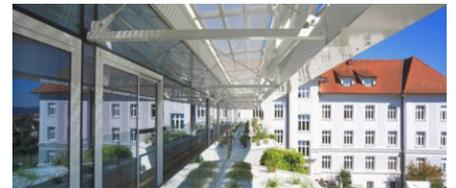
Im Auftrag der KAGES führte convex ZT GmbH die statisch-konstruktive Bearbeitung der Aufstockung des 2. OG durch. Die Tragkonstruktion der Aufstockung sind ausgesteifte Stahlrahmen, die Decken sind in Platten aus Kreuzlagenholz (KLH) ausgeführt.
